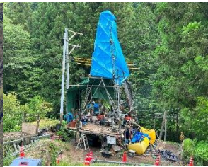
足場設備（B-40）
