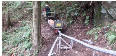
モノレール運搬状況（B-38）
