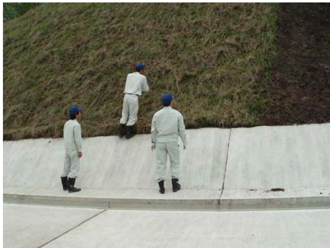
のり面の状況を確認し、問題ありませんでした。 (中野1号砂防えん堤、のり面)
