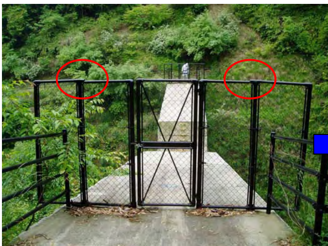
立入防止柵の損傷を発見し、応急対策を実施しました。 (四季が丘6号砂防えん堤、天端部)
