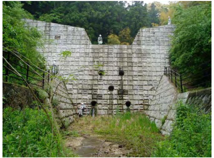
流路工の堆積土砂や、コンクリートのひび割れなどを確認し、問題ありませんでした。(四季が丘6号砂防えん堤下流部)
