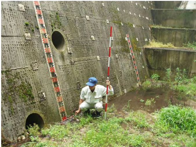
堆砂量や水抜き穴、コンクリートのひび割れなどの確認し、問題ありませんでした。 (相田2号砂防えん堤、堆砂域)
