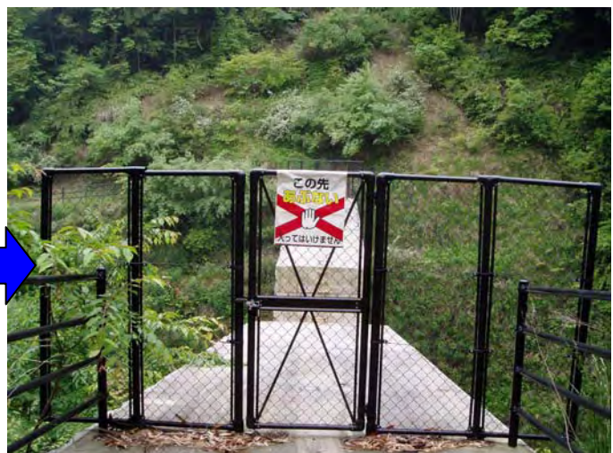
立入防止柵の損傷を発見し、応急対策を実施しました。 (四季が丘6号砂防えん堤、天端部)
