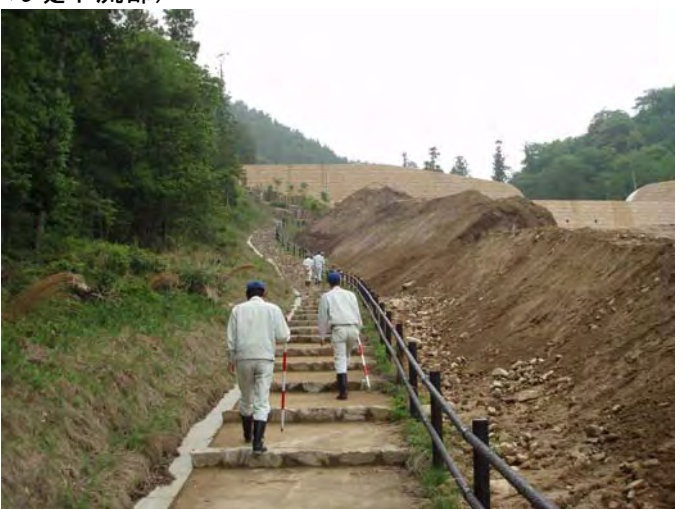
里道の安全施設確認し、問題ありませんでした。 (上ヶ原砂防えん堤)
