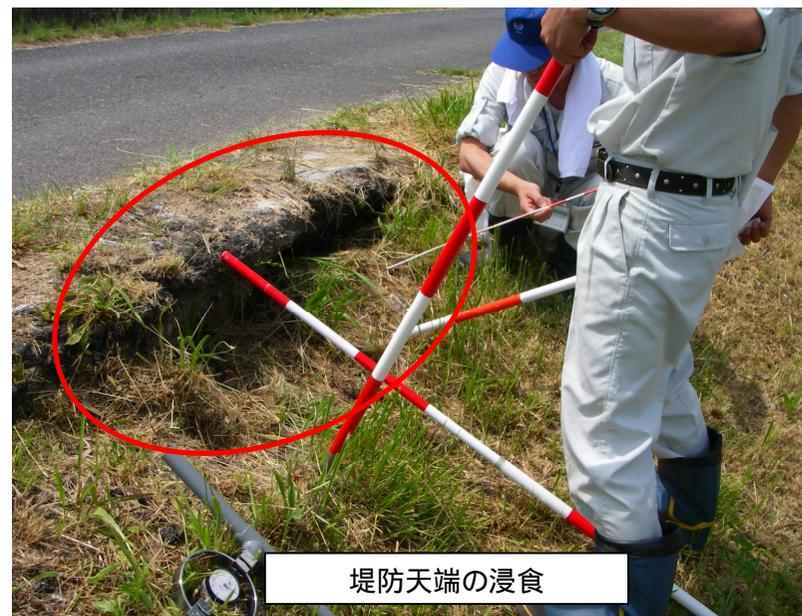
対策：土のう、土砂により浸食箇所の補修を実施
