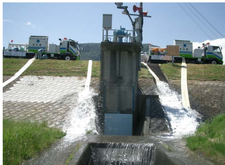
ポンプ稼働(排水)訓練(川側)
