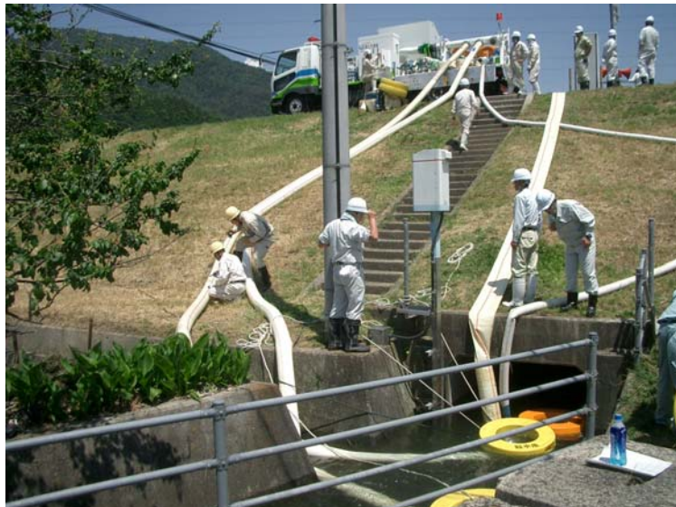
排水用ポンプの据付(宅地側)
