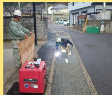
水路のふたを補修（緑井7丁目）
