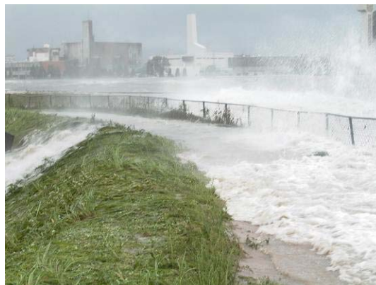
平成16年の高潮状況 (広島市西区観音付近)
