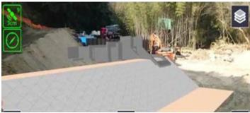
【ICT技術を用いた施工】 機械の可動域をデータで制御 しています。
