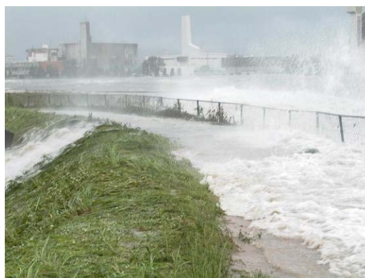
平成16年の高潮状況 (広島市西区観音付近)
