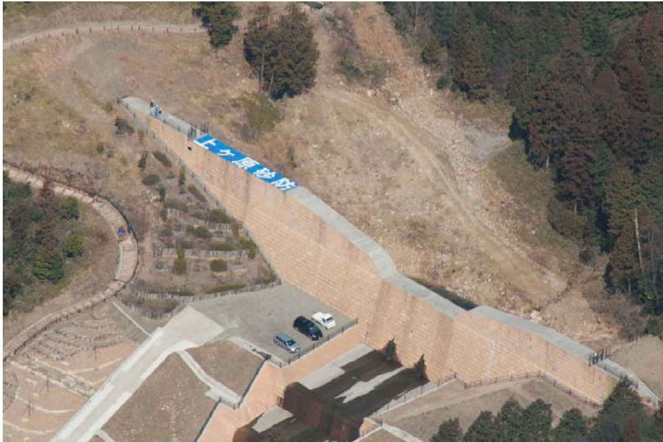
▲砂防堰堤への試験施工事例
