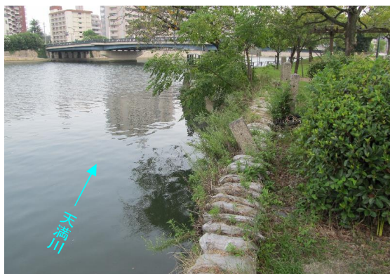
(写真) 堤防高不足により土のう設置
