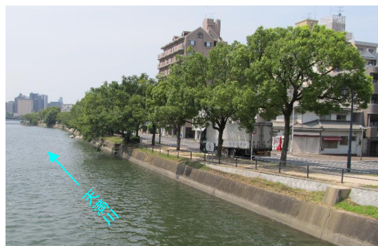
(写真) 緑大橋より下流の状況
