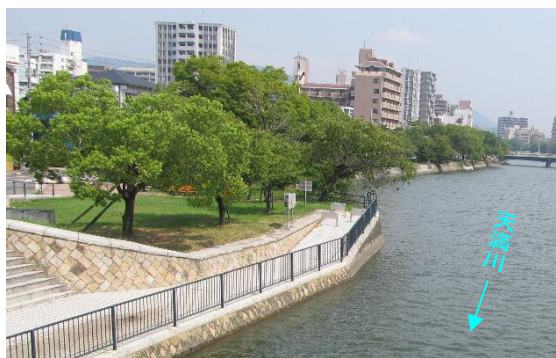
(写真) 観船橋より上流の状況
