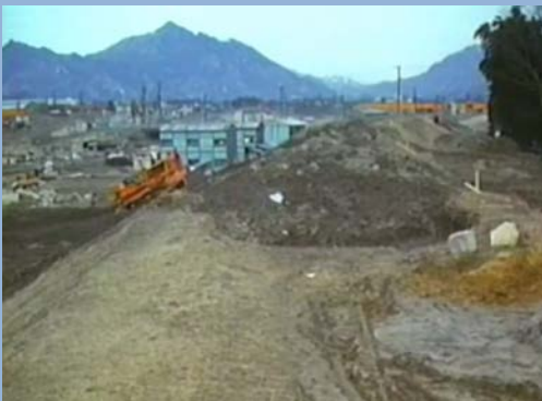
工事中の様子
