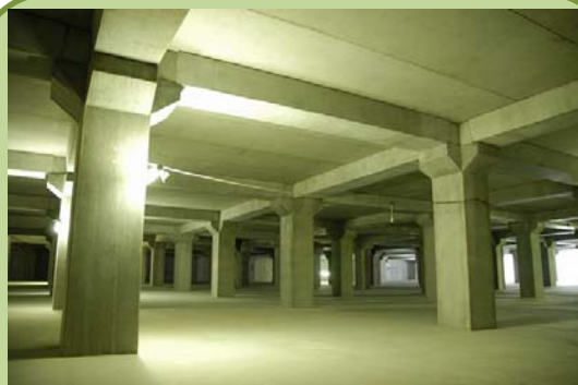
雨水貯留地内部の様子
