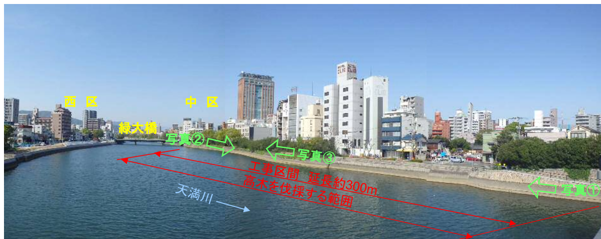
(写真) 観船橋付近より上流を望む
