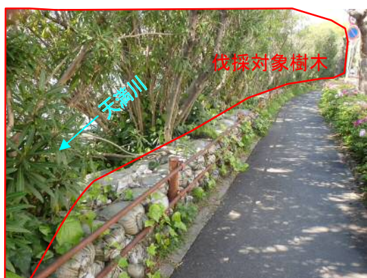
(写真③) 堤防高不足により土のう設置
