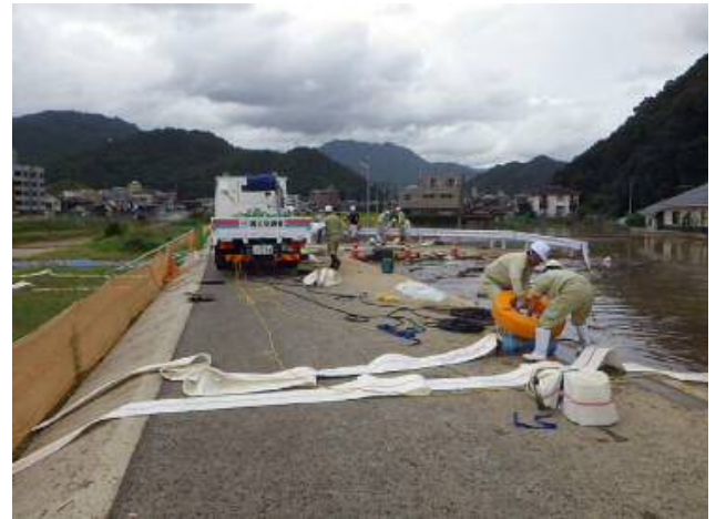
土砂崩れによる水路閉塞箇所での排水ポンプ車の設置及び排水作業
