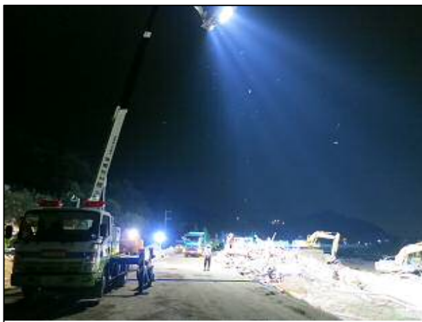
土砂崩れによる根谷川流出土砂の夜間撤去作業
