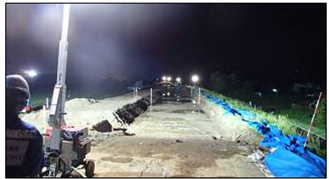
照明車の効果(照明車+工事用仮設照明)
