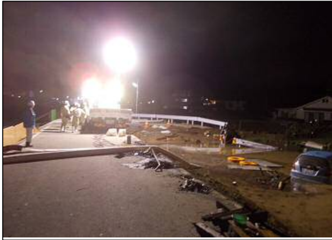
土砂崩れによる水路閉塞箇所での排水ポンプ車の設置及び排水作業
