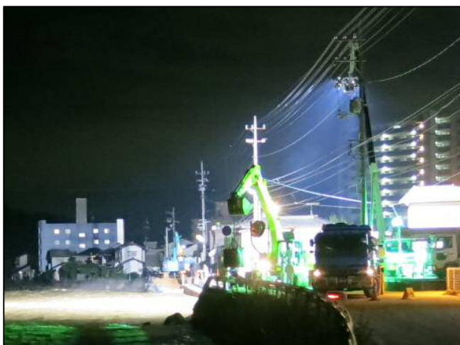
根谷川堤防護岸流出箇所の流出護岸の大型土のうと盛土による夜間応急復旧作業
