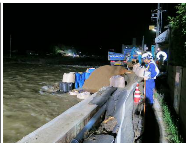
根谷川堤防護岸流出箇所の流出護岸の大型土のうと盛土による夜間応急復旧作業
