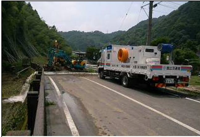
瀬田川河道閉塞直下流での排水作業
