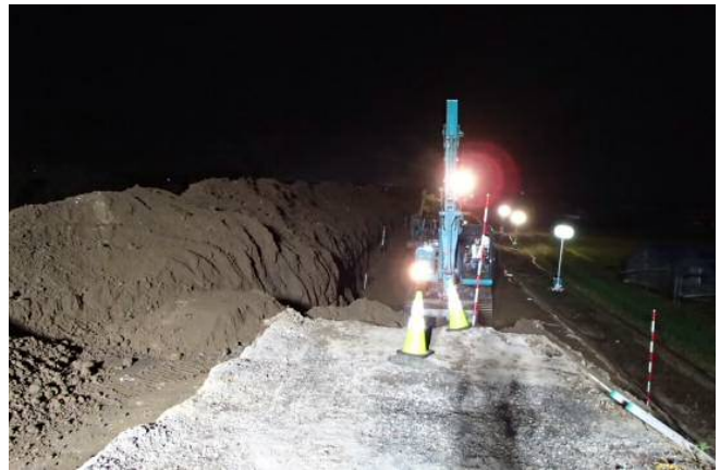
堤防の再構築作業
