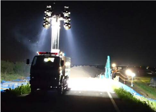
堤防の緊急復旧作業の照明支援
