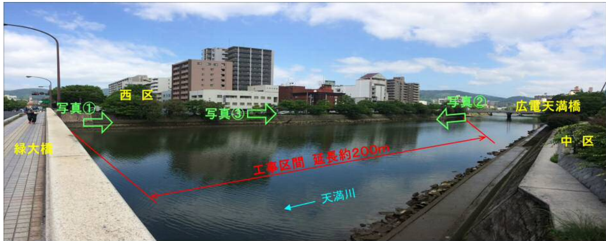
(写真) 緑大橋付近より上流を望む
