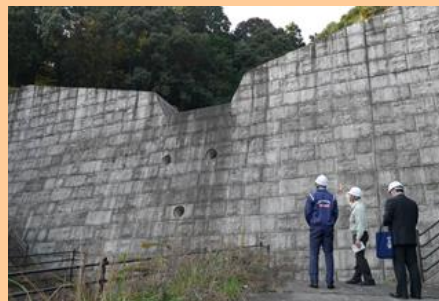
大町6号砂防堰堤視察
