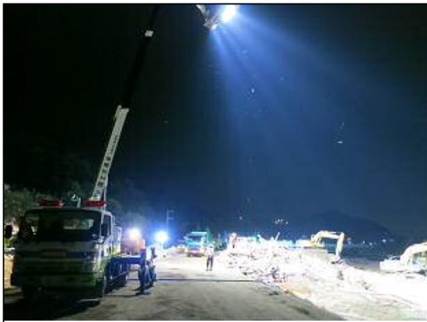
土砂崩れによる根谷川流出土砂の夜間撤去作業
