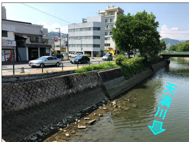
(写真①) 広電天満橋より上流の状況
