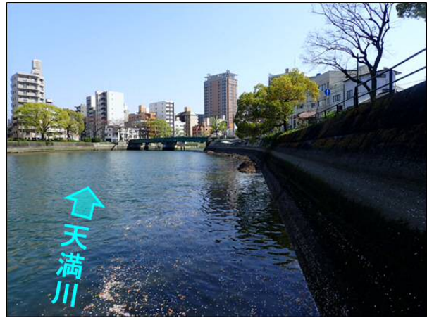
(写真②) 管理用階段より下流の状況
