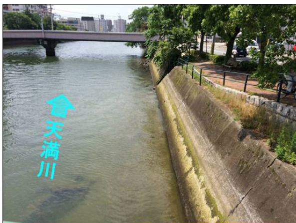
(写真②) 天満橋より下流の状況
