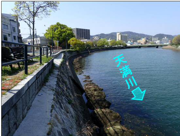
(写真①) 天満橋より上流の状況
