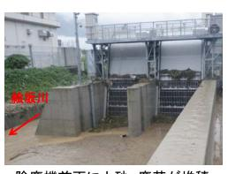
除塵機前面に土砂、塵芥が堆積
