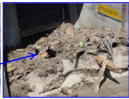
スクリーン前へ土砂の堆積が確認される
