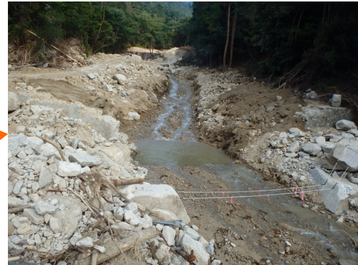
第2堰堤背面の掘削が完了 (流路断面の確保)
