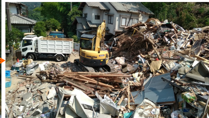
工事用道路(上流部)の促進
