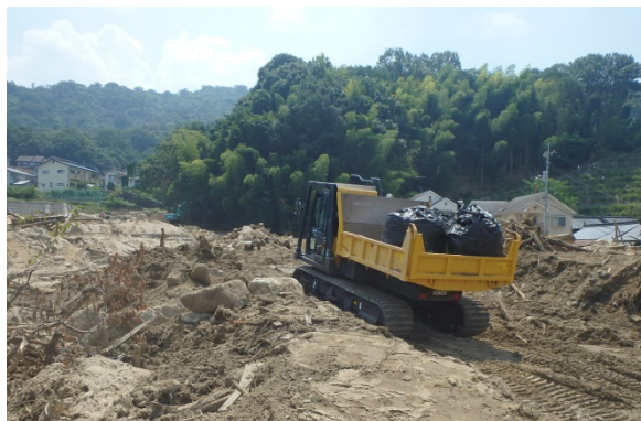
キャリアダンプによる大型土のうの運搬状況
