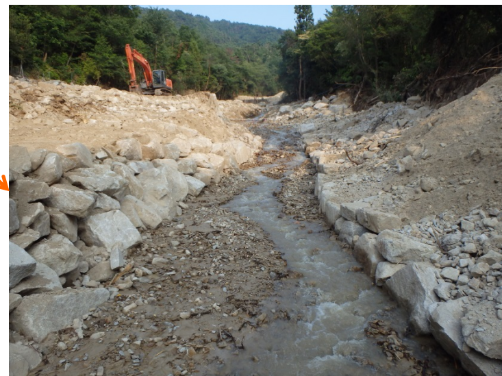
第1堰堤背面の掘削が完了 (流路断面の確保)
