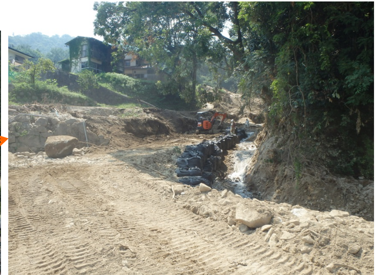
工事用道路の促進(流路工と兼用)
