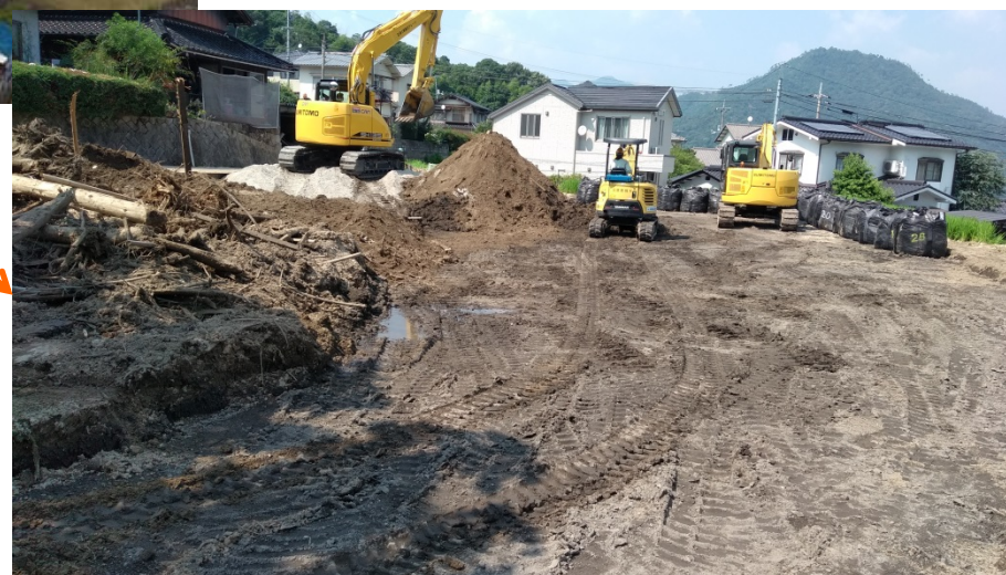
工事用道路(下流部)の促進
