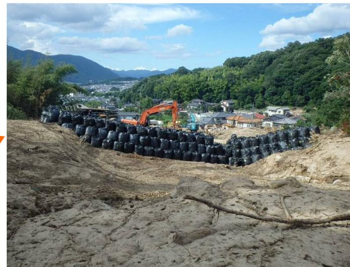
導流工(大型土のう)の完成
