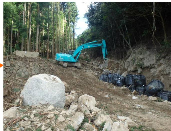
工事用道路の延伸(導流工設置位置まで到達)
