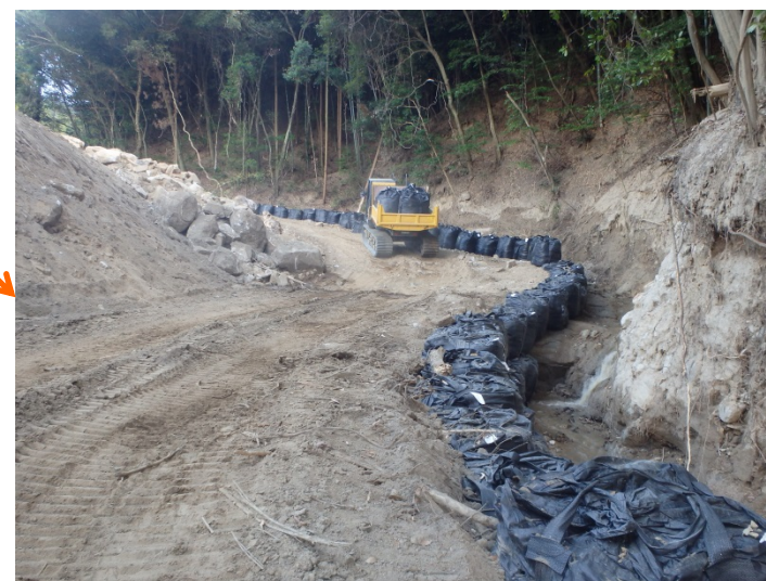
流路工が完成(7/23)
