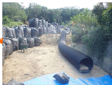
流路工(排水管の設置状況)の促進
