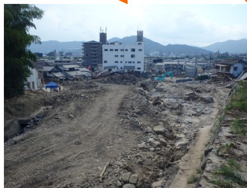
工事用道路の延伸
