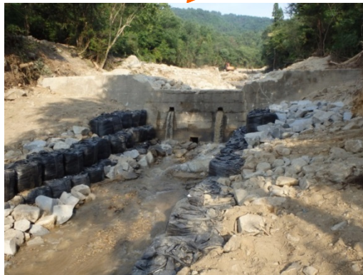
流路工が完成(7/18) (堰堤下流の洗掘防止)
