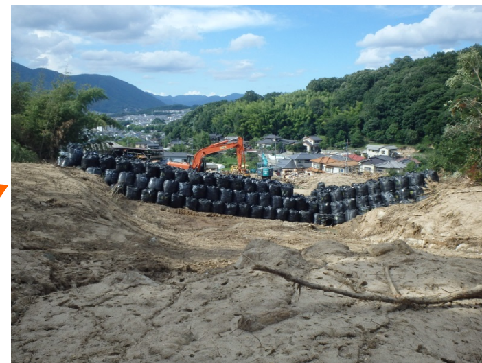
導流工が完成(7/22)
