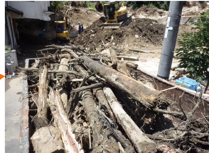
工事用道路(上流部)の延伸 ※)ガレキ撤去を含む
