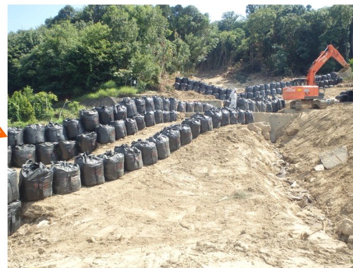
流路工(流路部の施工状況)の促進
