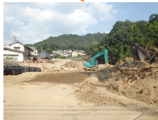
工事用道路の整備状況
