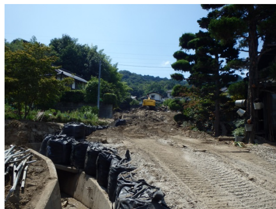
流路工の延伸 (既設水路部の堆積土砂撤去状況)
