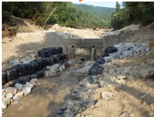
流路工が完成(7/18) (堰堤下流の洗掘防止)
