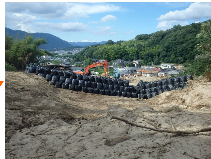
導流工が完成(7/22)
