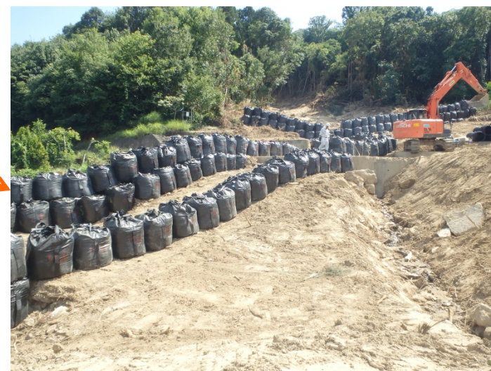
流路工(流路部の施工状況)の状況
