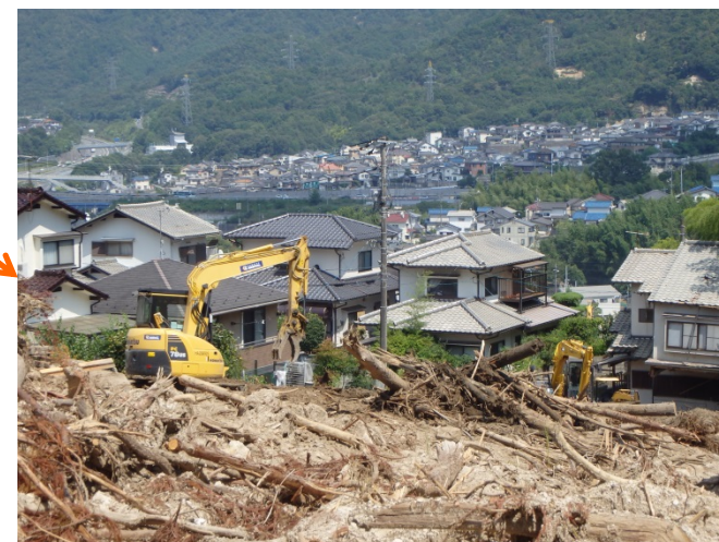
工事用道路(下流部)の延伸 ※)ガレキ撤去含む
