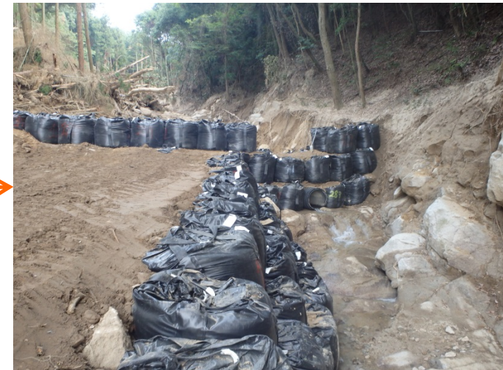
導流工が完成(7/24)
