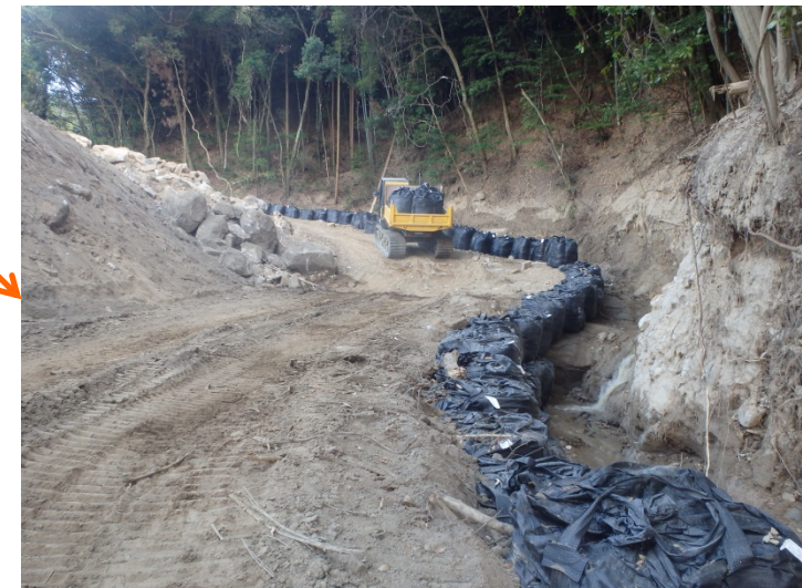
流路工が完成(7/23)
