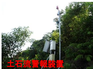
土石流警報装置設置完了(7/19)
