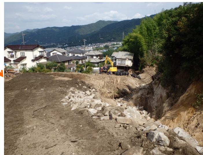
工事用道路の延伸(上流部工事用道路)
