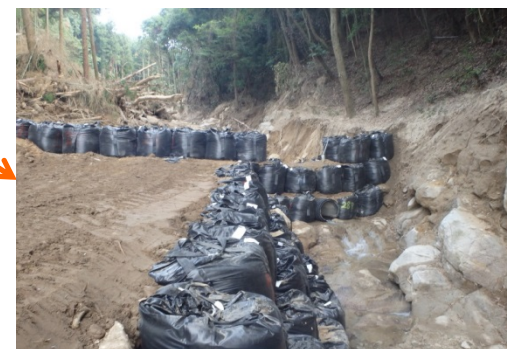
導流工が完成(7/24)
