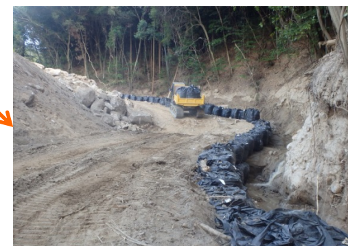
流路工が完成(7/23)
