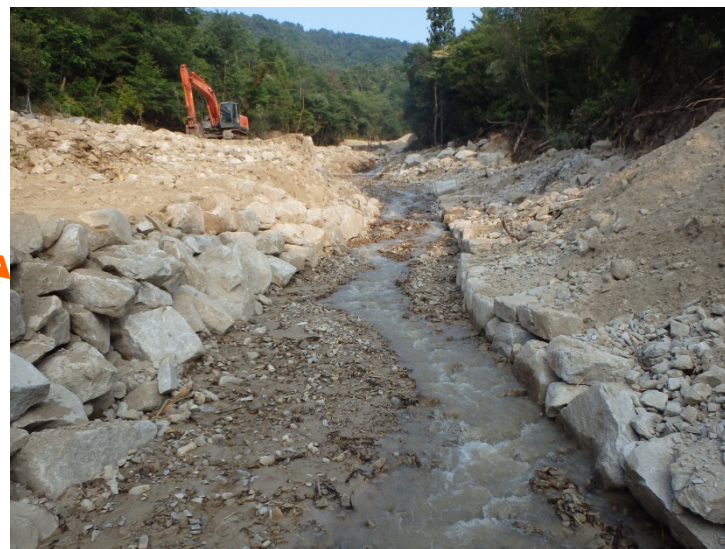
第1堰堤背面の掘削が完了(7/17) (流路断面の確保)
