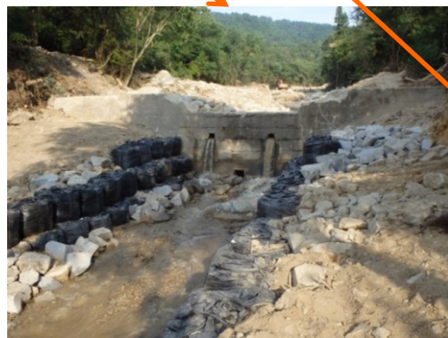
流路工が完成(7/18) (堰堤下流の洗掘防止)
