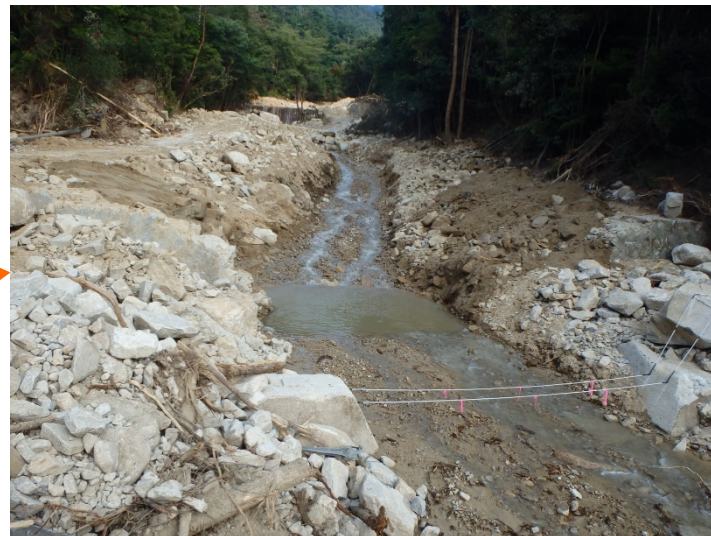
第2堰堤背面の掘削が完了(7/17) (流路断面の確保)
