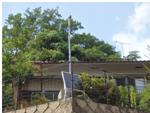
監視カメラ設置完了(7/28)
