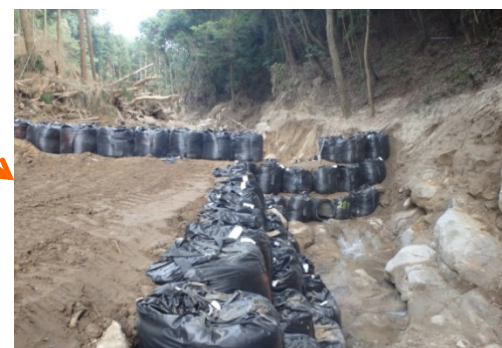
導流工が完成(7/24)
