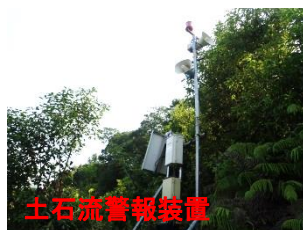
土石流警報装置設置完了(7/19)
