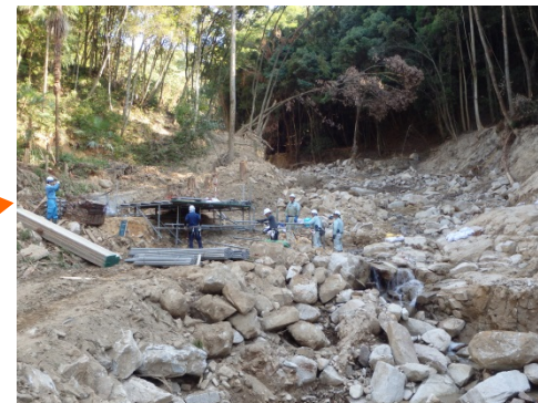
ワイヤーネットの足場工に着手(7/31)
