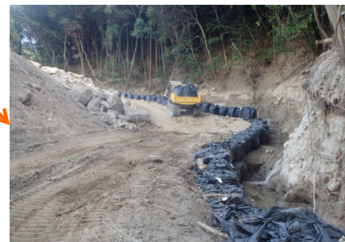
流路工が完成(7/23)
