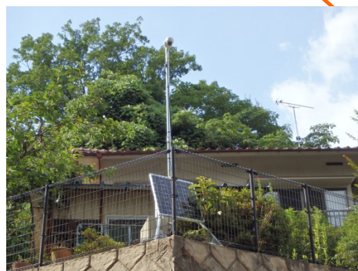
監視カメラ設置完了(7/28)
