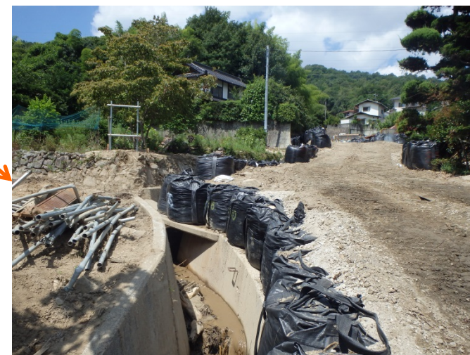
下流側流路工が完成(8/1)
