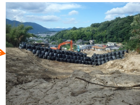
導流工が完成(7/22)
