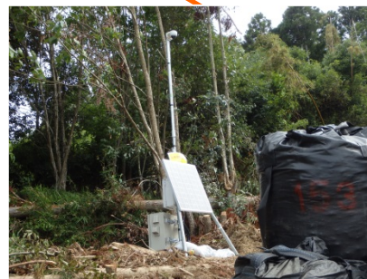
監視カメラ設置完了(7/28)
