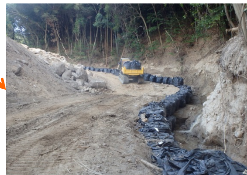
流路工が完成(7/23)
