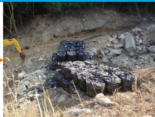
導流工が完成(8/3)
