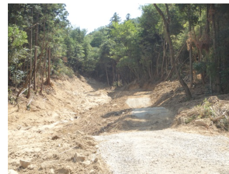
ワイヤーネット進入路が完成(7/31)
