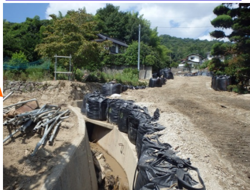
下流側流路工が完成(8/1)
