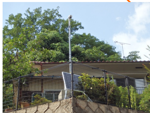
監視カメラ設置完了(7/28)
