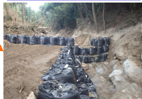
導流工が完成(7/24)
