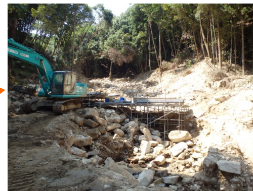
ワイヤーネットの足場工の促進
