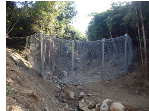
ワイヤーネット工が完成(8/30)
