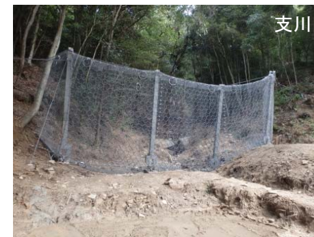
ワイヤーネット工完成(本川9/12、支川9/17)
