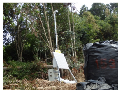
監視カメラ設置完了(7/28)
