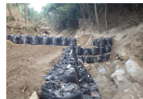
導流工が完成(7/24)
