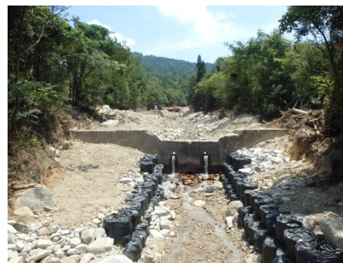
流路工が完成(7/18) (堰堤下流の洗掘防止)
