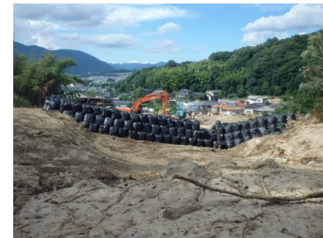
導流工が完成(7/22)
