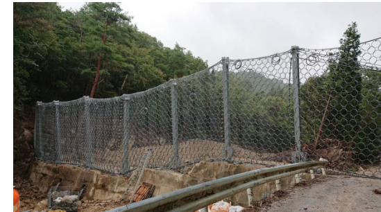
ワイヤーネット工(本川)が完成(8/31)
