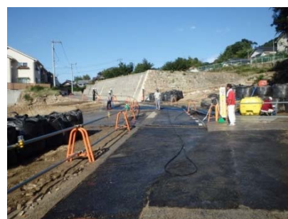
市道の仮復旧完了(9/5)
