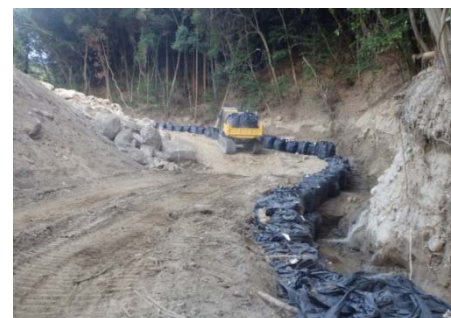
流路工が完成(7/23)
