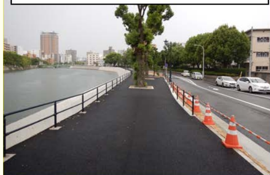
③天満川上天満町地区高潮堤防工事
