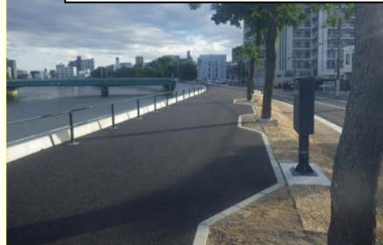
②天満川上天満町地区堤防工事
