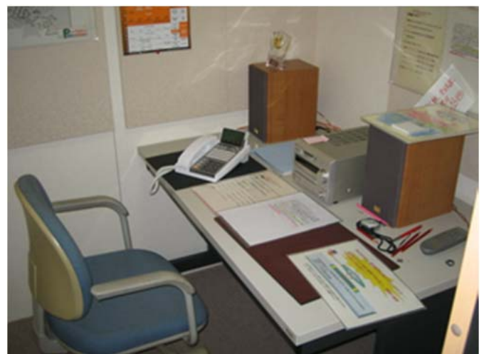
緊急割り込み放送施設
