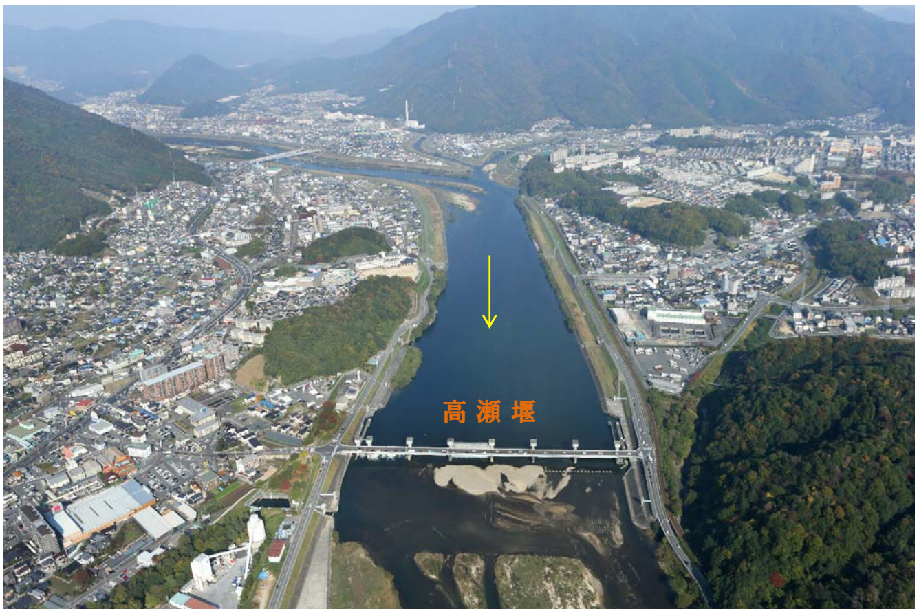
高瀬堰斜め写真（H25年撮影）
