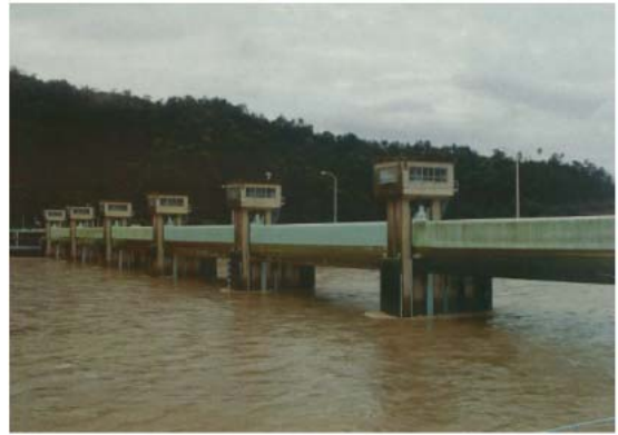
平成18年9月(秋雨前線)高瀬堰付近
