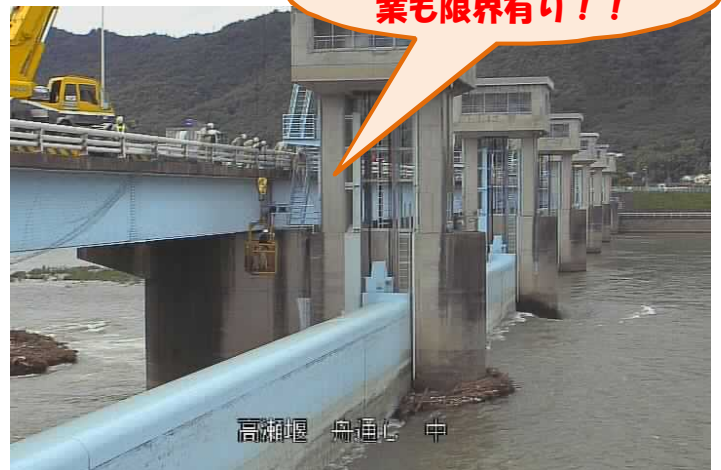
高瀬大橋よりゴンドラを使って 水面まで降りて撤去作業
