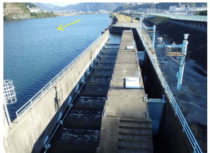
左岸側魚道・舟通し
