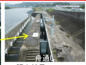
✓ 普段は閉まっている舟通しのゲートを 下流側から片方ずつ開けて、遡上する 魚類等を上流に呼び込みます。
