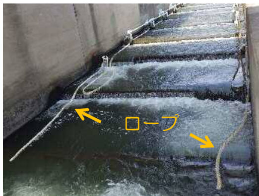
両岸の魚道に設置されたロープ（写真は左岸魚道）
