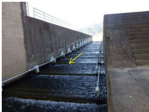
左岸階段式魚道
