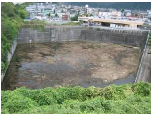
図 3-5 矢口が丘防災調整池
