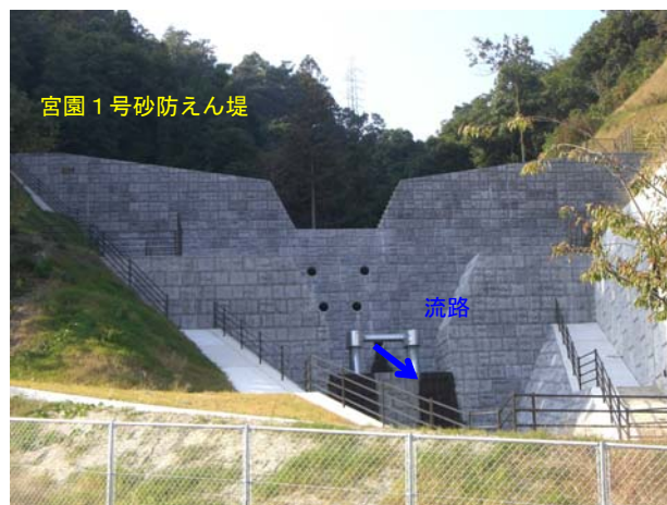
完成後の状況
