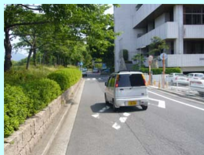
基町環境護岸と周辺の公園などとは道路で分断されている。
