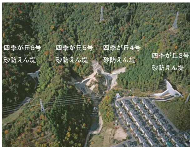
工事中の状況
