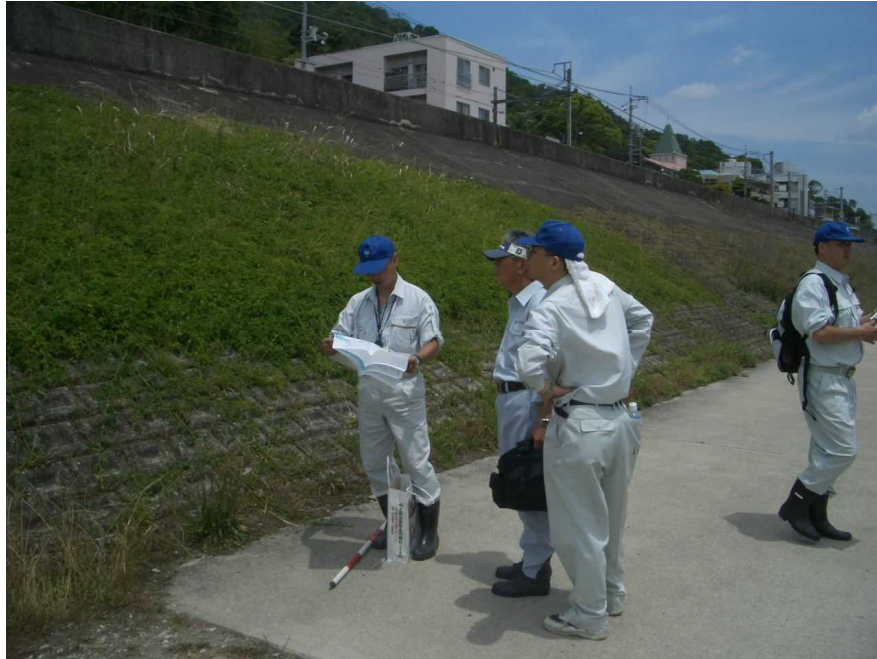
太田川放水路左岸側
