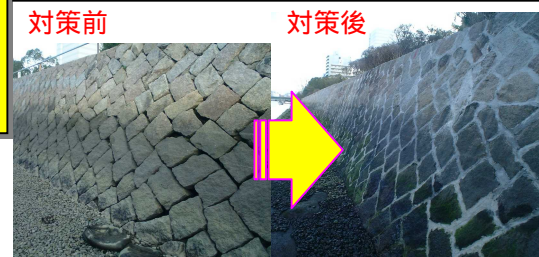
グラウトによる空洞化補修の例
