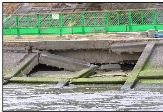
護岸背面の土砂の吸い出しによる空洞、緩みの発生により護岸が崩壊した事例 (写真左:旧太田川 写真右:太田川放水路) 施設損傷箇所は復旧済み
