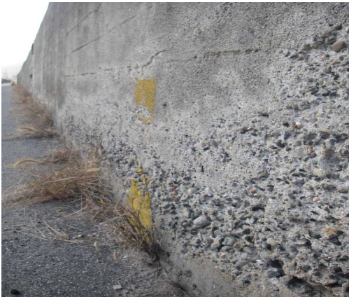
ひび割れが生じている護岸
