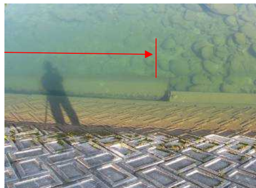
施設前面の河床低下により護岸損傷した事例 (写真左: H23年太田川 写真右: H22太田川) 損傷箇所は復旧済み
