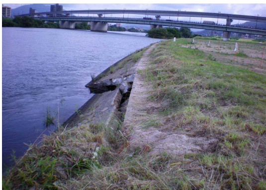
施設前面の河床低下により護岸損傷した事例 (写真左: H23年太田川 写真右: H22太田川) 損傷箇所は復旧済み
