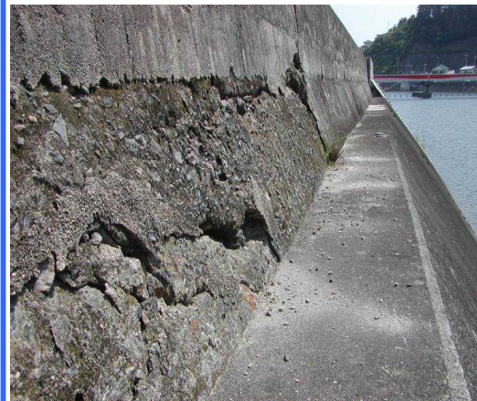
ひび割れが生じている護岸
