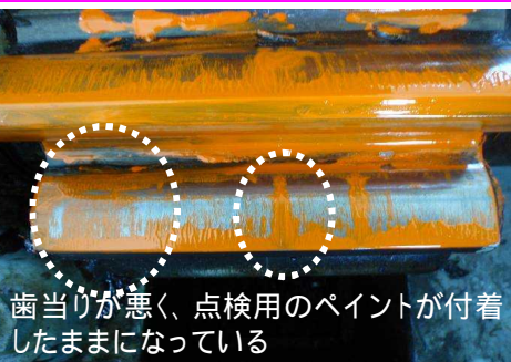
更新年次を迎えた樋門の不具合事例
