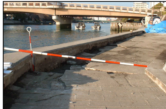
護岸背面の土砂の吸い出しによる空洞、緩みの発生により護岸が崩壊した事例 (写真左:旧太田川 写真右:太田川放水路) 施設損傷箇所は復旧済み
