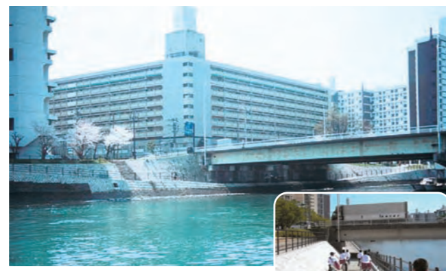
橋梁アンダーパス
