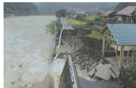
平成17年台風14号被災状況
