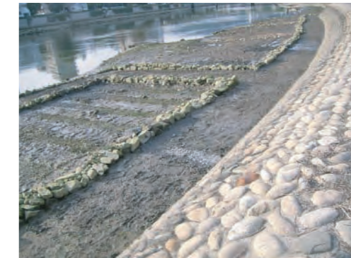
石炭火力発電所から出る石炭灰を粒状に固めた「石炭灰造粒材」を埋め込んだ状況です。
