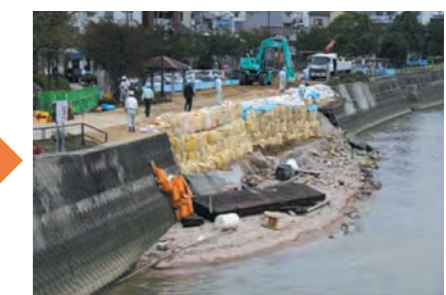
平成16年9月7日19:30~8日2:30の間で、応急復旧を行いました。
