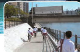
北大橋東詰アンダーパス
