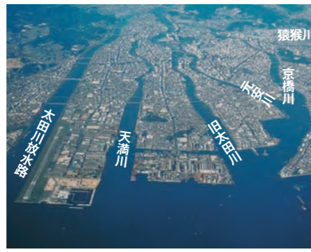
③市内派川(広島市)
