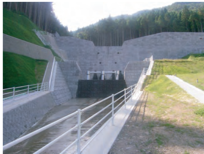
赤土地1号砂防えん堤(広島市佐伯区:平成20年9月完成)
