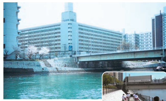
橋梁アンダーパス
