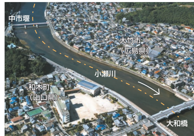
④ 大和橋から中市堰
