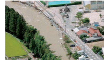
平成17年9月台風14号による支川玖島川の被災状況
