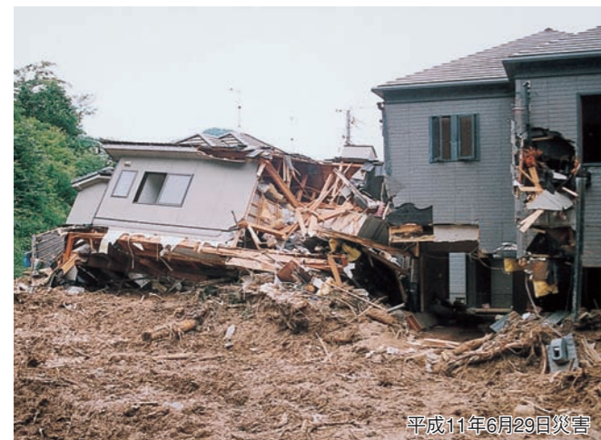
安川左支川(広島市安佐南区) (写真提供:広島県砂防室)
