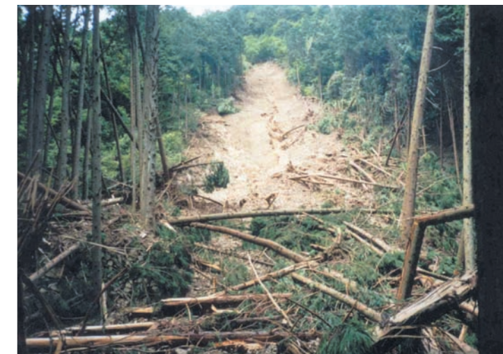
風化した花崗岩(マサ土)の崩壊状況 平成11年6月29日災害 (写真提供:広島県砂防室)
