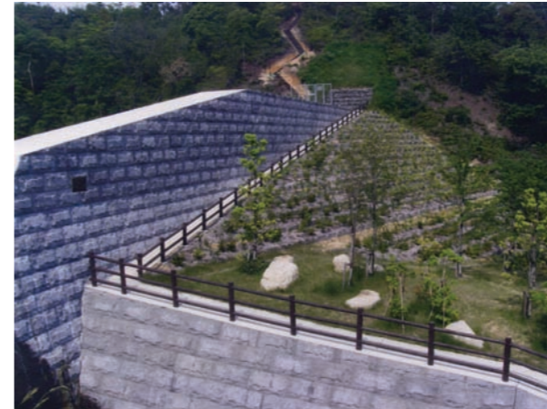
下流側を植樹した湯舟砂防えん堤(大竹市湯舟地区)
