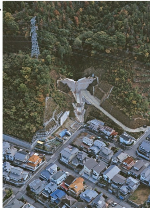
相田3号砂防えん堤(広島市安佐南区相田地区:平成19年5月完成)
