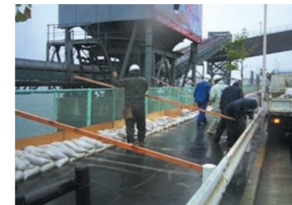
事前に潮位を予測し、土のうを設置
