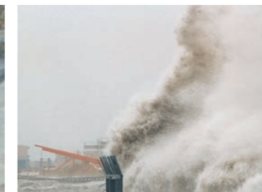
平成11年9月災害 越波状況 天満川右岸観音新町
