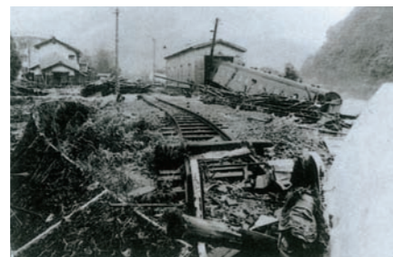
昭和47年7月豪雨 加計付近被災状況
