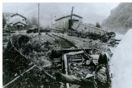
昭和47年7月豪雨 加計付近被災状況
