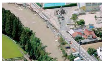
平成17年9月台風14号による支川玖島川の被災状況
