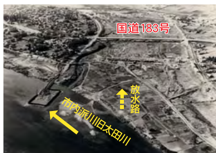
工事中の大芝・祇園水門(昭和38年)
