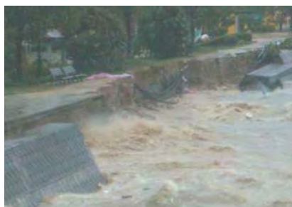
平成16年9月7日16:00頃(吉島橋の下流左岸側)
