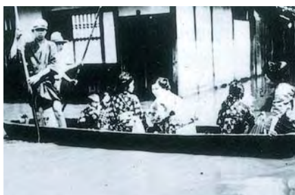
大正12年6月洪水 広島市白鳥町浸水状況 (写真提供:広島市公文書館)
