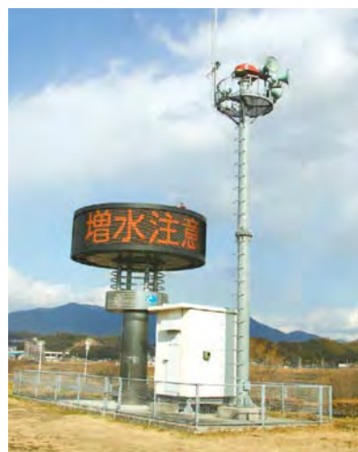
高瀬堰 中調子警報所および情報表示板 (広島市安佐南区東野地先)
