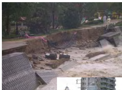
高潮による旧護岸の被災状況 (旧太田川)
