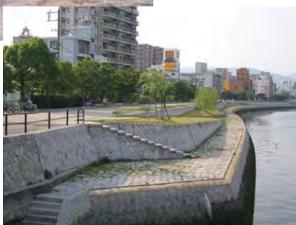
元安川における高潮堤防整備状況
