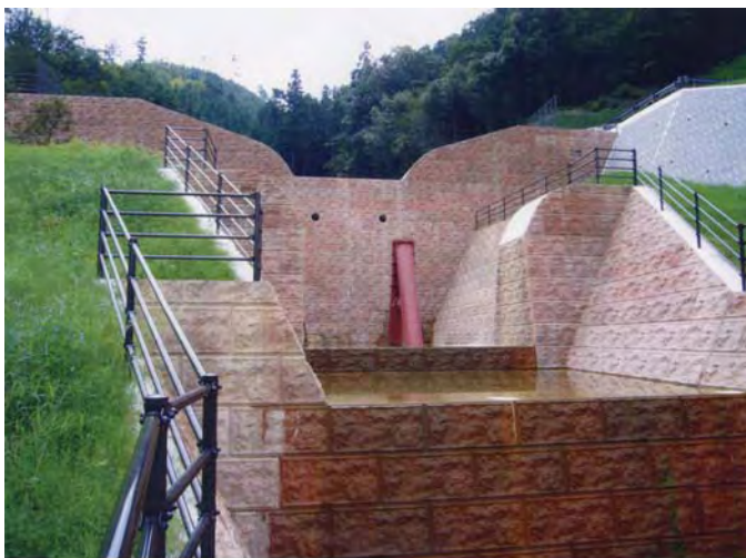
海田ヶ原砂防えん堤(広島市安佐南区相田地区:平成18年8月完成)
