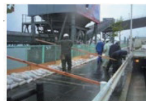
事前に潮位を予測し、土のうを設置
