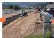
応急復旧状況
