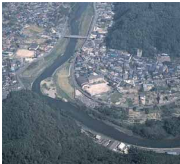
小瀬川5.0k付近
