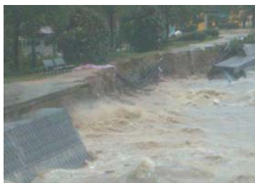
平成16年9月7日16:00頃 (吉島橋の下流左岸側)
