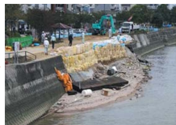
平成16年9月7日19:30～8日2:30 の間で、応急復旧を行いました。
