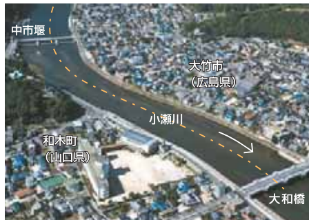
⑤大和橋から中市堰
