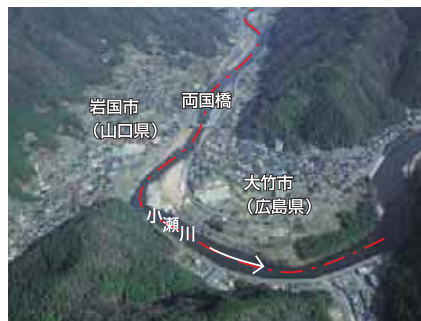
④両国橋付近(小瀬川5K付近、下流より望む)
