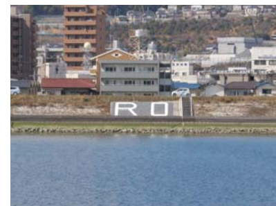
対岸からの様子(太田川放水路)
