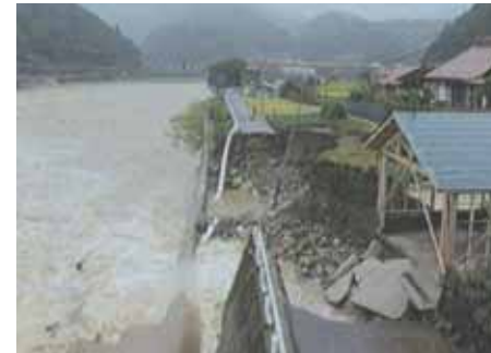
平成17年9月台風14号被災状況 (安芸太田町加計地先)
