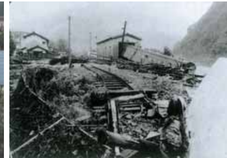
昭和47年7月豪雨被災状況 (安芸太田町加計付近)
