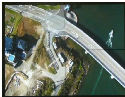
ラジコンヘリによる上空調査状況
