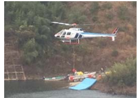
水位計の投下
